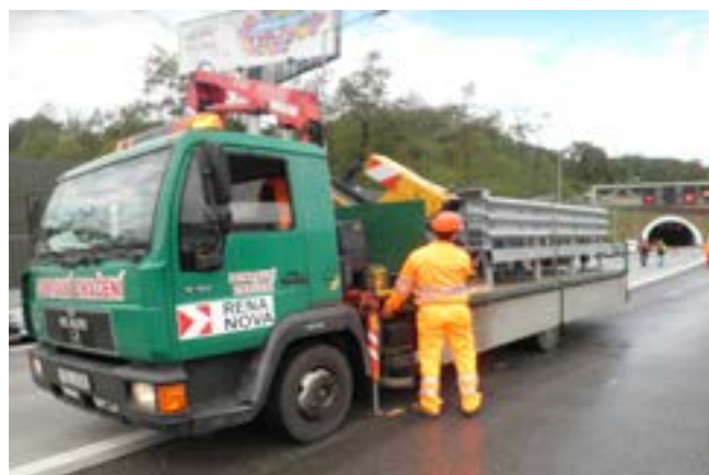
La dimostrazione dell'installazione di un S-A-B
